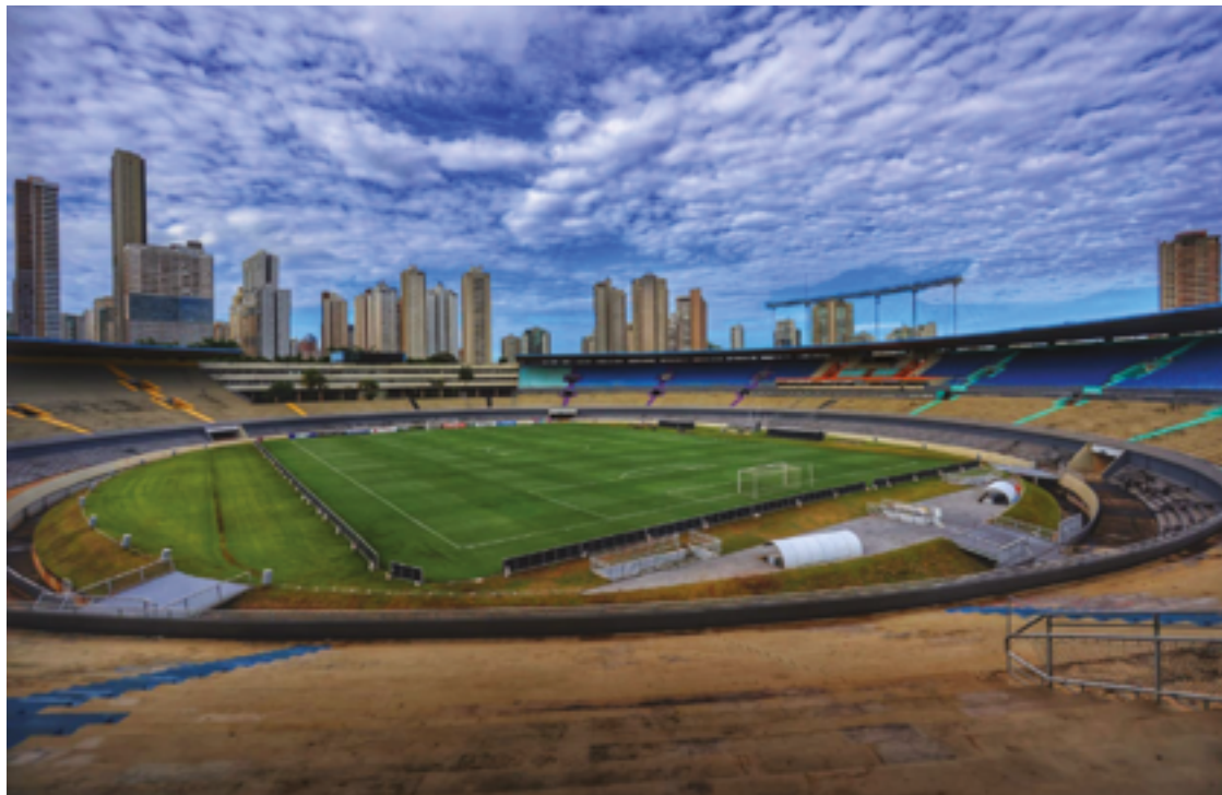
Modernização do estádio incluirá a construção de camarotes, novas arquibancadas e um centro multiuso
